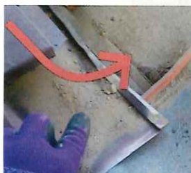
瓦の裏側に雨水の流れ道が
