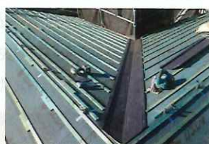
谷板金と桟木の取り付け
