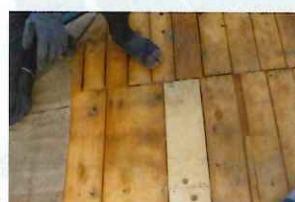
新しい下地に張り替え
