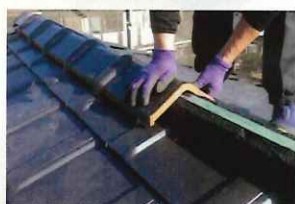
棟瓦の取り付け
