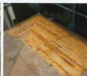
防水シートの撤去
