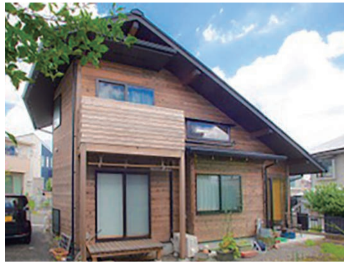
延べ床面積62㎡とコンパクトながら、工夫がいっぱいのH邸
