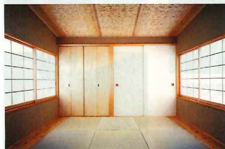
和室の天井は葎簀張り、壁は聚楽壁
