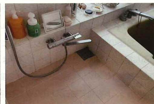
バスタブを収めるスペースは、シャワー水栓の 立ち上がり面と同じ位置で仕切られていました
