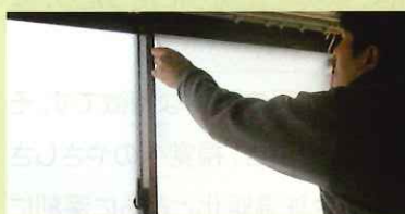
フィルムを貼り、ガラスとの間に空気が残らないように処理
