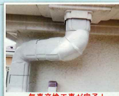
無事交換工事が完了!
