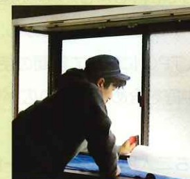
工事当日。ガラスを清掃し、専用の界面活性剤を塗布
