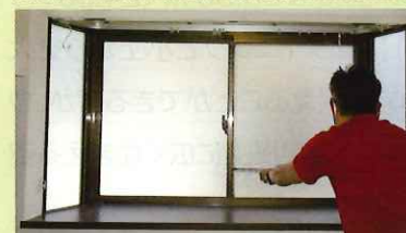
事前に窓ガラス寸法を正確に測り、フィルムを準備
