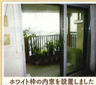
ホワイト枠の内窓を設置しました
