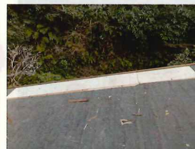
新しい下地板を張りました
