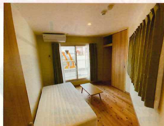
窓廻りの壁にセラミック断熱塗料を塗布
