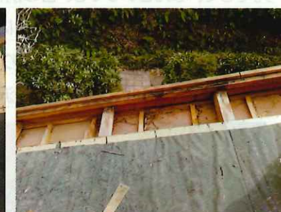
傷んだ下地をはがし
