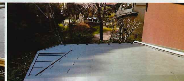
グリーン系のガルバリウム鋼板で仕上げました
