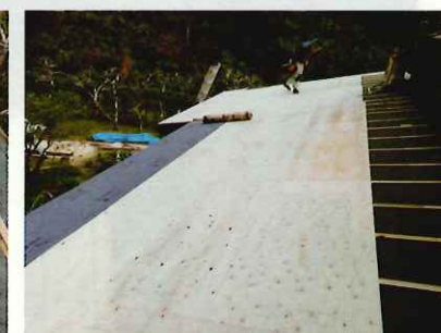
垂木の上に新しい下地材を載せ防水ルーフィングを貼りました
