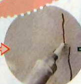
接着材塗布後、 コーキング充填
