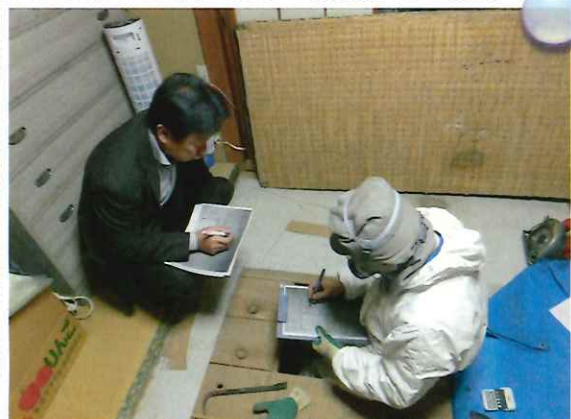
耐震診断で、床下から筋交いの状況などを確認
