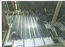
【床暖房工事】 このように発着目のない1本の温水管が床全体を暖めます。
