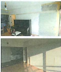
(上) 漆喰塗り途中のリビング (下) 無垢バインフローリングの洋室 工事費用: 約1,120,000円(税込み)
