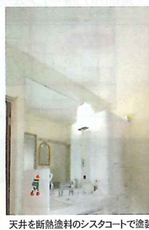
天井を断熱塗料のシスタコートで塗装
