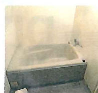
施工後のY邸浴室
