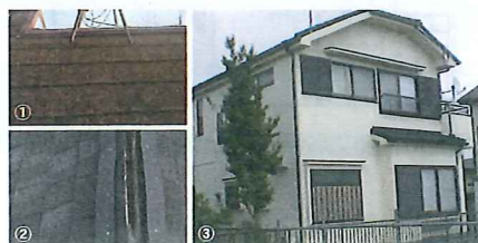
① 24年経過したスレート屋根 ② オベロンに葺き替え、開口部は換気棟用 ③ 外壁塗装はASシリカコートで施工
