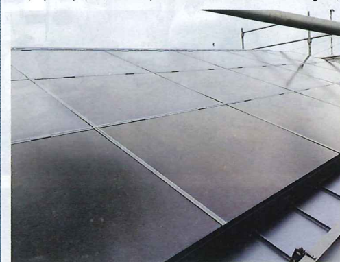
ソーラーフロンティアの CIS 太陽電池 (銅、インジウム、セレン)
