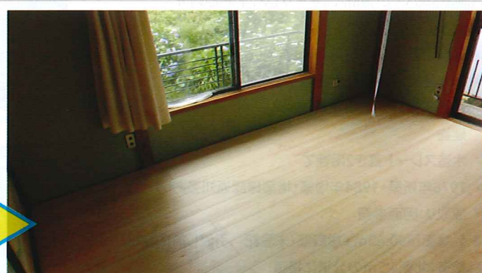
東濃ヒノキ無垢床材は、生産地で天然ワックス仕上げを施しています
