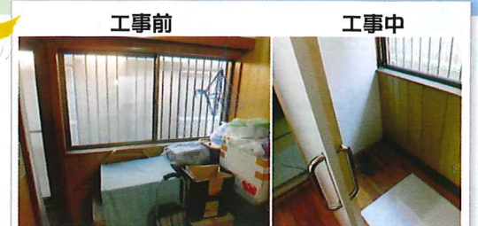
荷物置きに重宝していた 2 階ホールにトイレを新設
