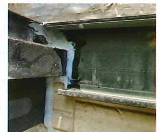
接合部すべてコーキングを施工
