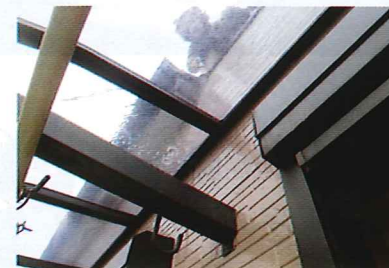
徹底した水かけ試験 + 室内の雨漏り箇所を開口して水の道を探す
