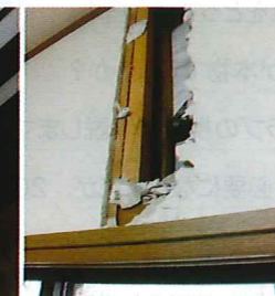
徹底した水かけ試験 + 室内の雨漏り箇所を開口して水の道を探す
