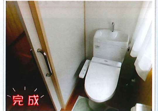
内装は、掃除が容易な白色ポリ合板仕上げ 床には、汚垂れタイルを埋め込みました 引戸は、開口の際に通路を邪魔しません 同時に階段手すりも設置しました
