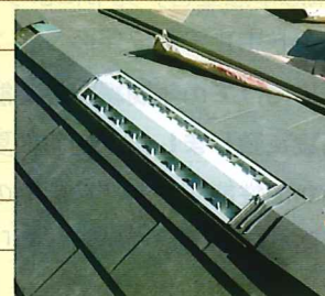
屋根の棟部分にこのようにスリットを入れます
