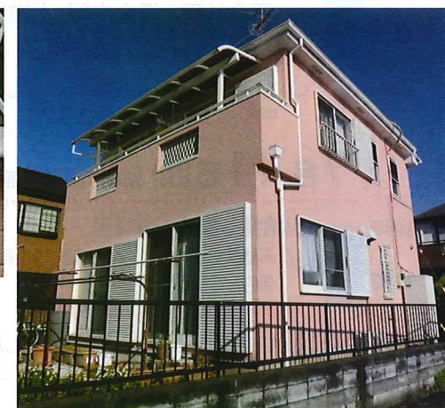
外壁全体の塗装後の様子
