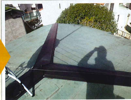
工事完了。塗装は屋根塗装の際に一緒に。
