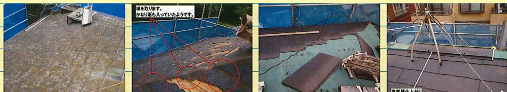
① 工事前の屋根の様子 ② 屋根材表面を剥がしてみるとあちこちに激しい傷みを見つめます。 ③ 新たに高耐久性防水下地を敷きスレート葺きで仕上げました。 ④ 屋根裏換気ができるように換気棟を追加設置しました。
