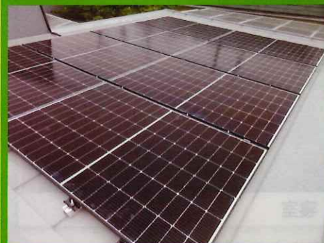
🌞 発電モジュールの設置。この面で8枚
