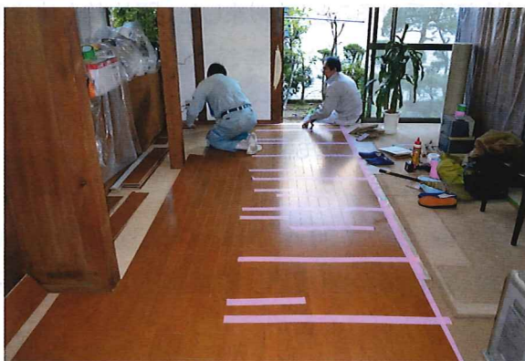
温水シートの上にフローリング貼りの作業中
