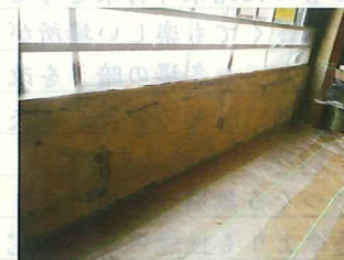
傷んでいたクロスは事前に組合員の皆さんで剥がし済み、周囲が汚れないよう養生をします。
