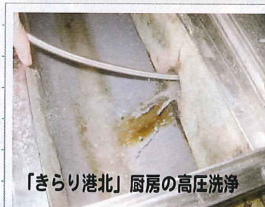
高圧洗浄機。1平方センチメートルあたり150kg以上の水圧を出すことができます
