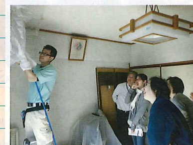
* 水濡れ予防のためシートで養生してから、石けんと水の高压洗浄で汚れを落とします。実演担当は馬上(もうま)さん
