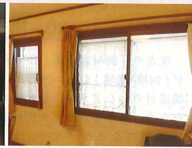
■リビング：上げ下げ窓形式のインナーサッシはないため、そこには内開き型を取り付けました。
