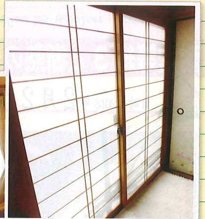
■和室：障子を外して、障子の棧のデザインのまま、すりガラスのインナーサッシに入れ替えました。
