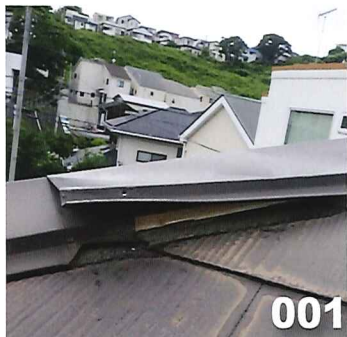
屋根に上がった悪質業者によって壊された桧板金
