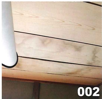
1階の和室天井の雨染み
