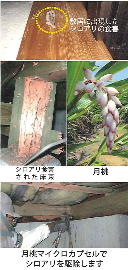
敷居に出現したシロアリの食害 シロアリ食害された床束 月桃 月桃マイクロカプセルでシロア리를駆除します
