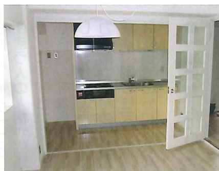
リフォーム前 ダイニングから独立した壁付けキッチンでした
