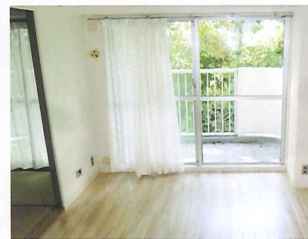
リフォーム前 壁はビニールクロス 床は合板材でした
