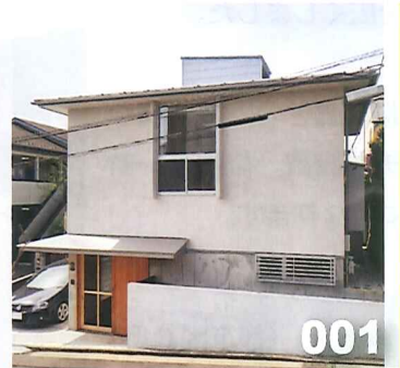
ドイツ漆喰の外壁
