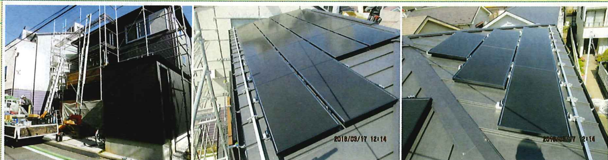
● 部分足場を架け、電動昇降機で機材を屋根に持ち上げます
