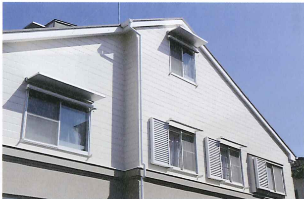
★夏の強い西日を防ぐために庇(ひさし)と外付けスクリーンを設置しました。
