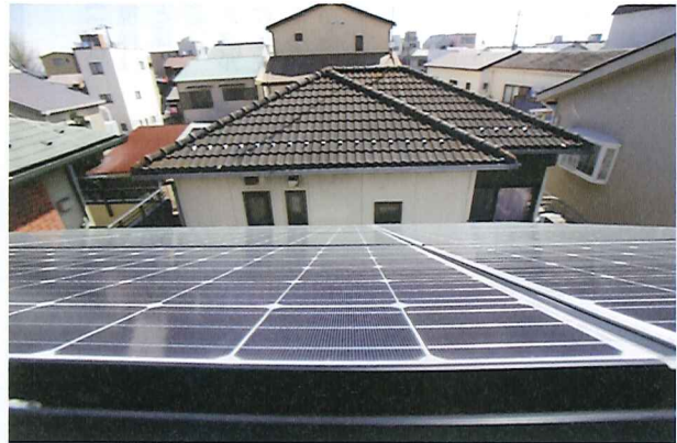
★3階のバルコニーから、太陽光発電(2.88kW)を見下ろすことができます。
