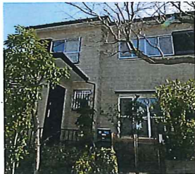
外壁施工後のA邸
