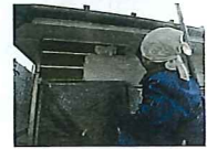
下塗り含めて3回塗り施工
