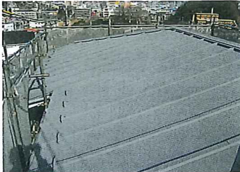
屋根に断熱塗料施工したA邸
