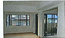
マンションの内壁に断熱塗料
