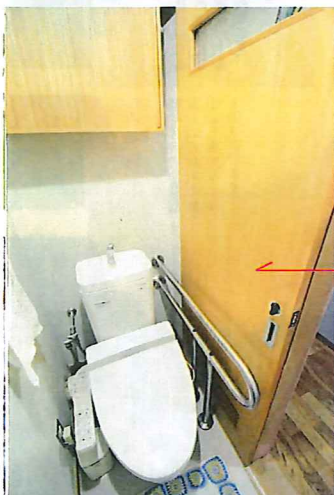
★床レベルを上げ、すべて段差なしバリアフリーになりました。
