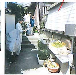
★濡れると滑りやすい玄関ポーチを滑りにくいモルタル仕上げに変更。
